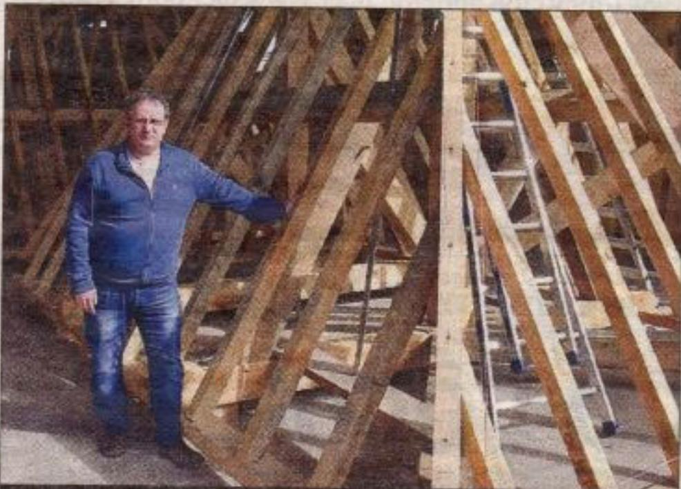
**CHARPENTE.** Les charpentes des bas-côtés de la cathédrale de Nevers sont en construction dans les locaux de l'entreprise Dulion.
