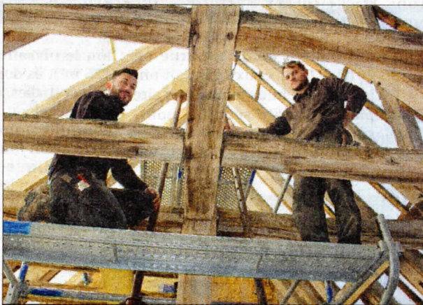
OUVRAGE. Les charpentiers de l'entreprise Dulion sont à l'œuvre dans l'abside de l'église Sainte Marie-Madeleine.
