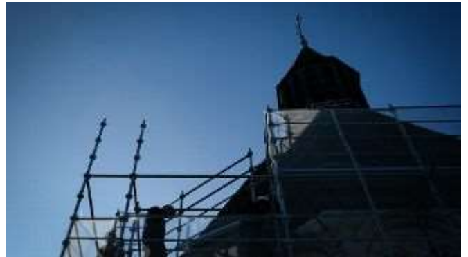
Vue du prieuré et des personnels qui travaillent sur l'échafaudage
