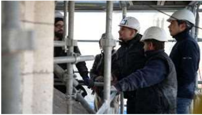
Discussions des différents corps de métier sur les travaux du prieuré.
