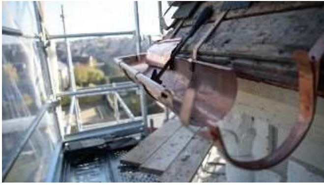
Les gouttières du prieuré sont refaites.
