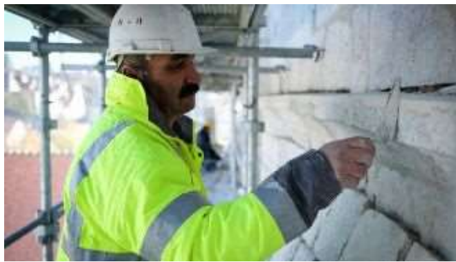
Un maçon travaillant sur la façade du prieuré de La Charité.
