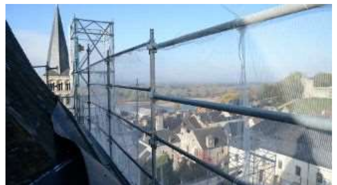
L'échafaudage a été monté jusqu'au toit de l'église, d'où on peut voir le département voisin du Cher.
